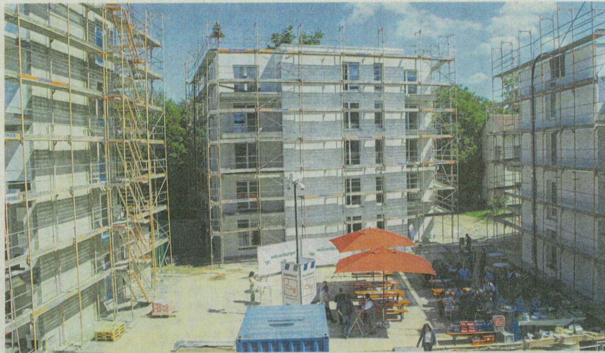
Drei Baukörper mit drei Besitzern: Mit der Vermarktung der Mietwohnungen im künftigen Parque Monterey soll nun begonnen werden. Sie haben meist zwei bis drei Zimmer und sind 55 bis 80 Quadratmeter groß.
